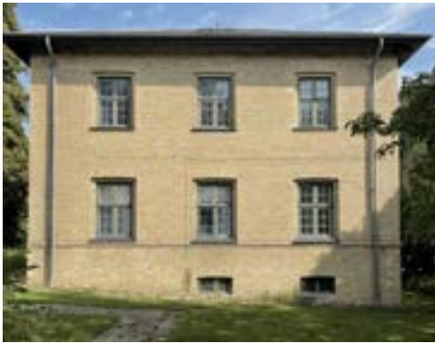
Fig.47. Facade mod vest på Vesterhus.
