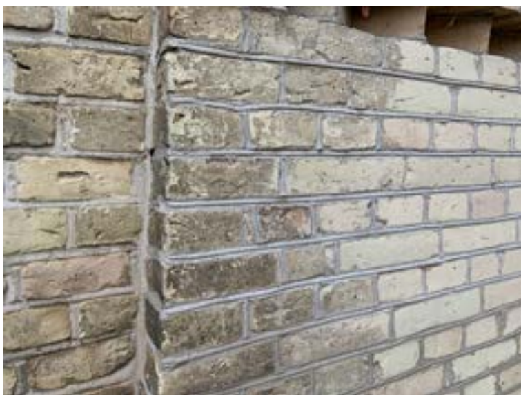
Fig.38. Det er vigtigt at fastholde bygningsdetaljerne, så nyt passer til gammelt. Det gælder skiftegangen - også kaldet forbandtet - og teglstenenes format, farve, tekstur og patina. Det gælder også fugetypen. Fotografiet viser, hvordan skiftegang og brændte fugetype er fastholdt ved en reparation af facaden. Her er brugt en skiftegang med rækker af skiftevis løbere (langsiden på teglstenen) og kopper (den korte side af teglstenen). Fotografiet viser også, hvor tydeligt en reparation skiller sig ud, hvis man ikke rammer rigtigt med stenenes farve.
