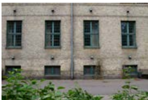
Fig.35. Tagrender og nedløbsrør skal udføres i zink uden synlig overfladebehandling. For at tilpasse tagrender og nedløbsrør til de bevaringsværdige bygninger bør de udføres med samme detaljering og befæstigelse som oprindeligt med loddede eller falsede samlinger og knæk (bajonetknæk). Rendejern bør udføres med vulst.
