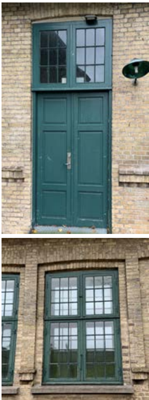
Fig.32. Bygningsdetaljer som døre og vinduer spiller en særlig rolle for helhedsindtrykket på Sankt Hans. Det skyldes dørenes fine profileringer og vinduernes elegante, lette udtryk. Det er vigtigt at bevare området korskorsvinduer med tynde stålsprosser. Ny termovinduer vil give et helt andet udtryk, fordi karme, rammer og sprosser skal være meget kraftigere. Her ses et eksempel på en dør og et vindue på bygning 21 af Kurhus. Kalfatring omkring vinduer bør foretages med hydraulisk mørtel uden cement. De steder, hvor der oprindeligt har været dækningsliste, bør kalfatringen afdækkes med liste malet vogngrøn.
