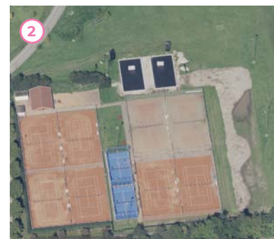
Padelbaner under opførelse
