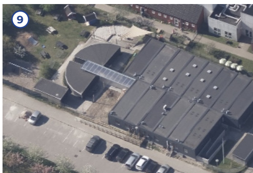
Børnehuset Akelejen i midlertidige lokaler
