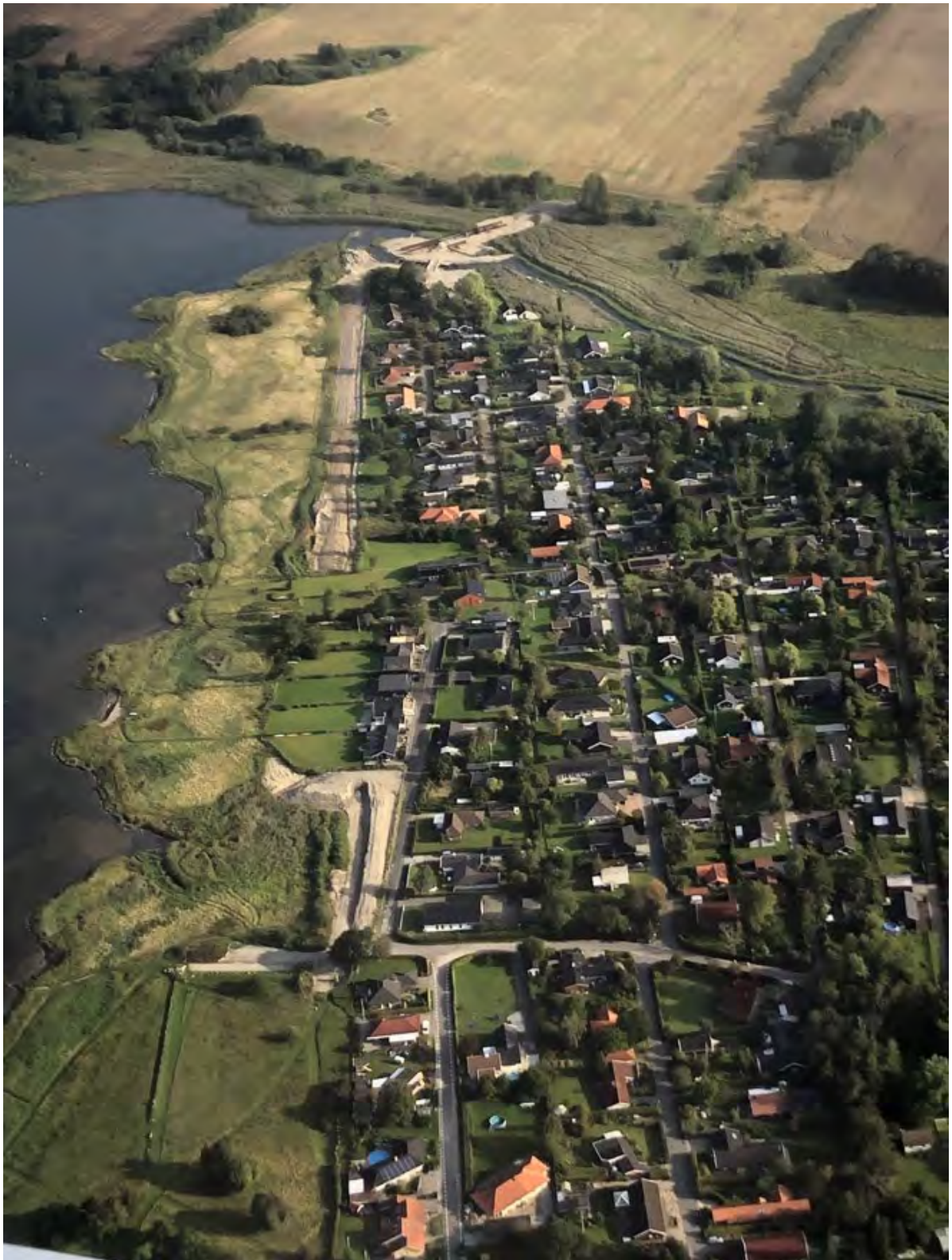
Figur 2-17 August 2019 (set fra syd) - Muld er afrømmet og byggeplads er etableret. Mod nord (øverst på fotoet) ses det oprindelige udløb af Værebros Å i Roskilde Fjord samt den midlertidige omlægning af åen.
