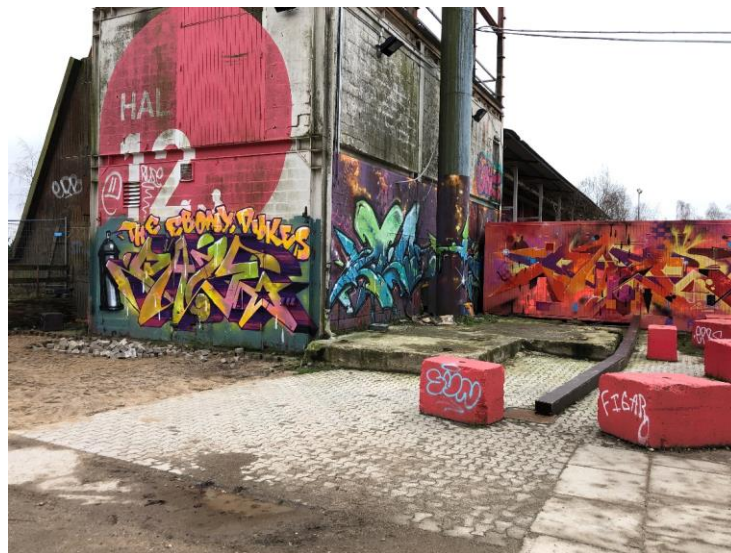
Figur 2-12 Foto der viser slambassinet fra nord. En træbjælke ligger hen over, se foto nedenfor.
