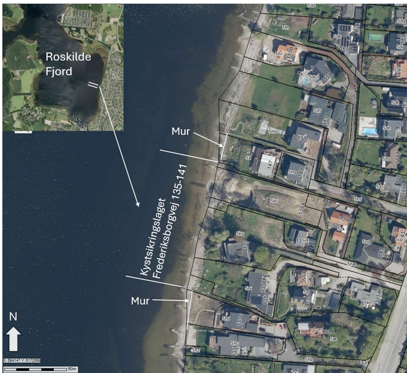
Figur 1.1: Kystsikringslaget Frederiksborgvej 135-141. Lige nord og syd for lagets område findes fremskudte stenmure, der støtter skræntens fod. Billede fra 2024.
