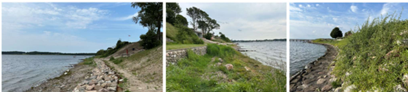
Figur 6.5: Til venstre: billede fra kyststrækningen foran Frederiksborgvej 135-141, der viser hvordan strækningen ser ud efter at spunsvæg og stenkastning er etableret (billedet er taget 17.6 2025) . I midten: strand på tilstødende område, der viser potentialet for bevoksning med strandvegetation. Til højre: stenkastning på tilstødende område, der viser potentialet for bevoksning på stenkastningen.
