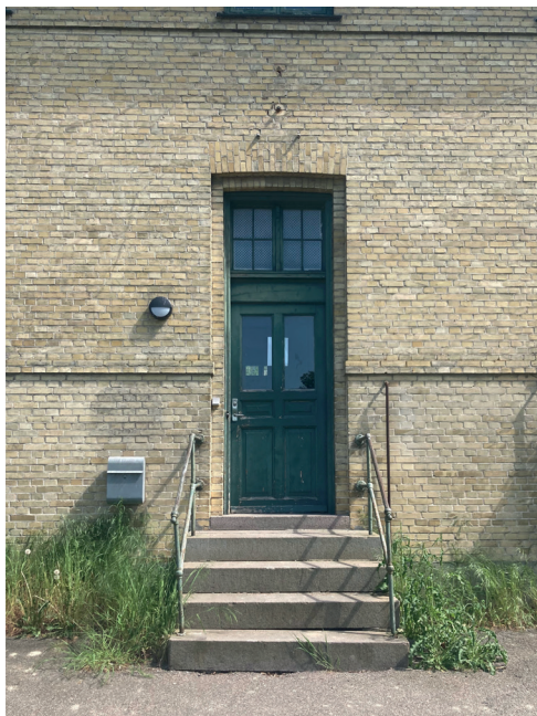
Fig.15. Hoveddøren til Nørrehus med granittrappe og gelænder. © Roskilde Kommune
