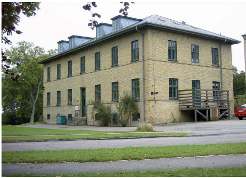
Fig.16. I sydgavlen er der etableret en udgang med en træterasse. Terrassen skal nedrives, og døren kan enten omdannes til fransk altan eller nyt vindue. © STARBAS
