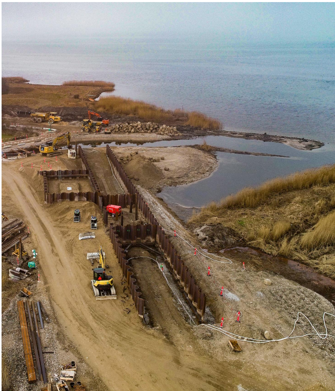
Februar 2019 – (fra nord mod syd) – spuns ved sluse er etableret og undergrund stabiliseret
