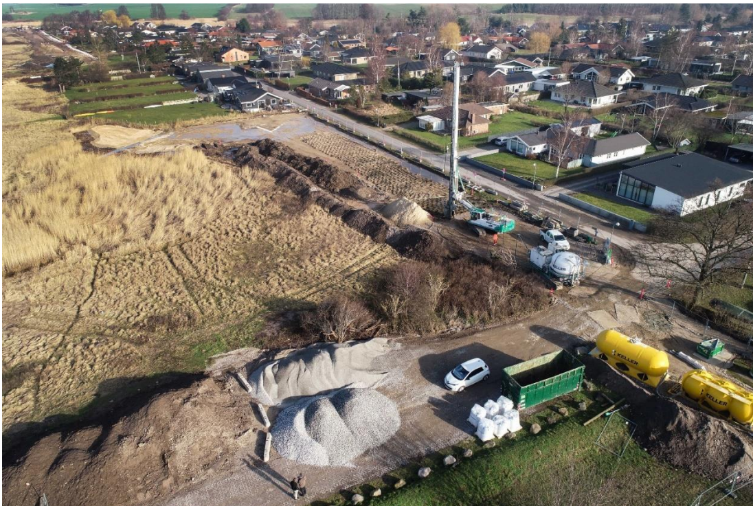
Februar 2019 – (fra syd mod nord) – Anlægsarbejde i private haver er ikke igangsat. Nord og syd for er undergrund stabiliseret
