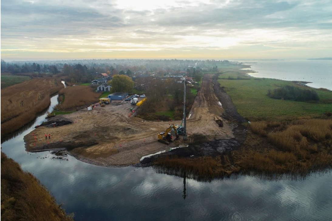
November 2018 – (fra nord mod syd) - Muld er afrømmet og byggeplads er etableret.
